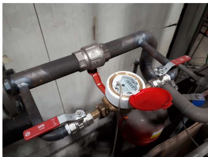
Slika 33. Turbinski protokomjer
