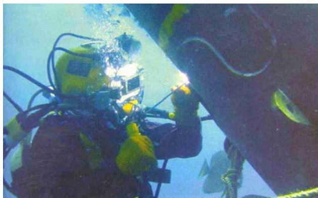
Slika 1. Podvodno mokro zavarivanje /1/
