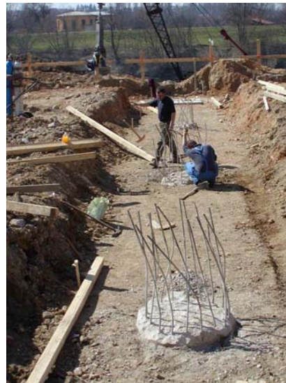
Fig. 12 Ground works Slika 12. Temeljni radovi
