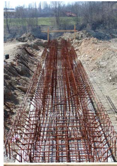
Fig. 13 Horizontal girders Slika 13. Vodoravni nosači
