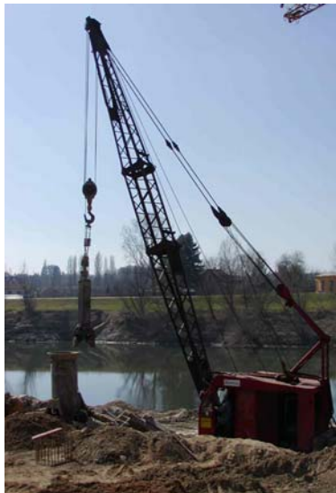
Fig. 11 Implanting pilots Slika 11. Postavljanje pilota
