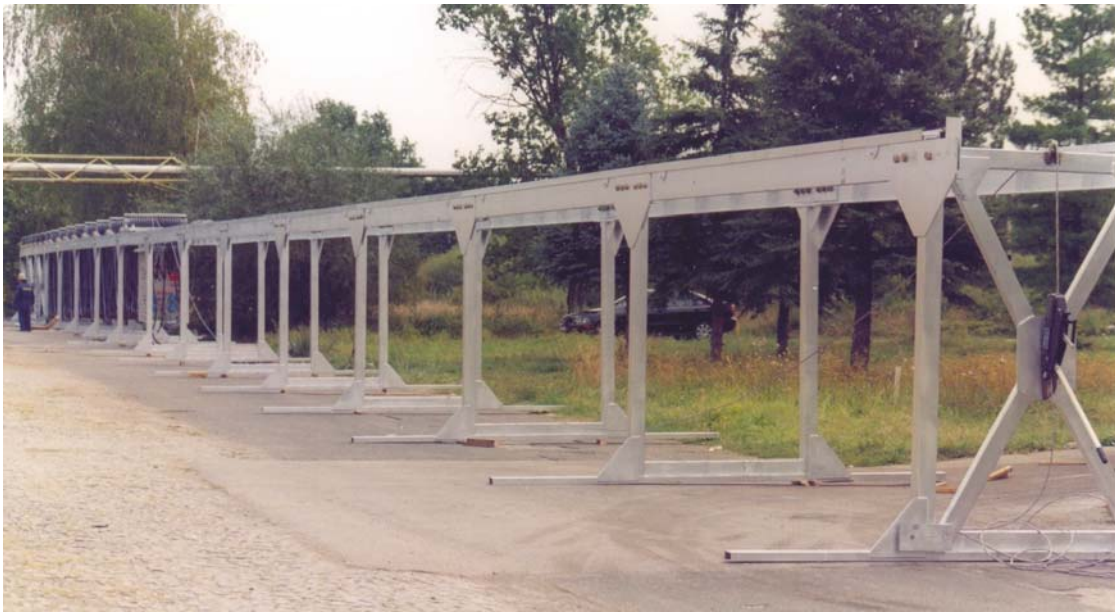
Slika 9. Postavljena staza za razvlačenje kabale
