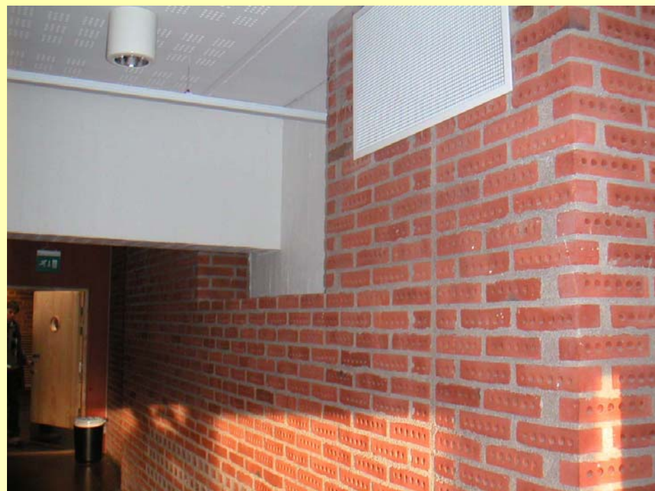
Odsisni otvori za zrak
