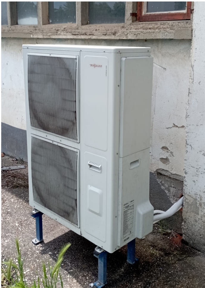
Vanjska jedinica dizalice topline zrak-voda
