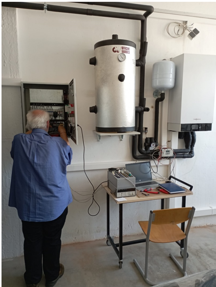
Polaganje napajanja mjerne opreme
