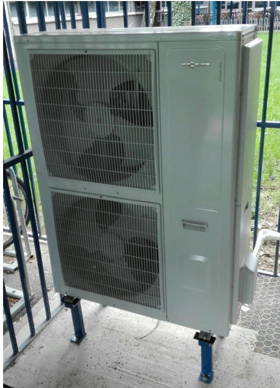
Vanjska jedinica dizalice topline zrak - voda
