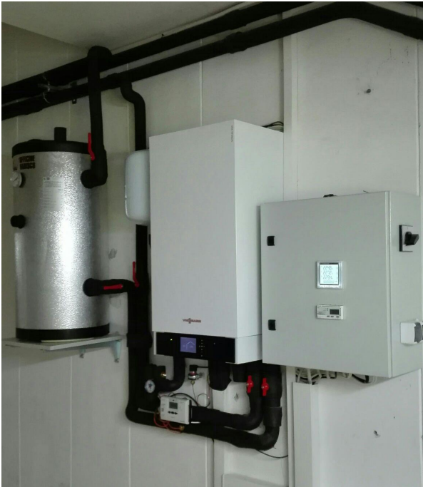
Unutarnja jedinica DT, upravljački ormar i inercijski spremnik
