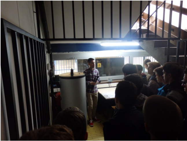
Geotermalna dizalica topline u radu
