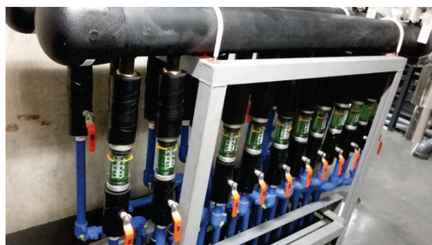
Razdjelnik/sabirnik izmjenjivača u tlu
