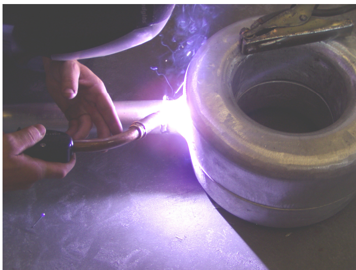
Slika 1 - 3: Zavarivanje torusa i cijevi
