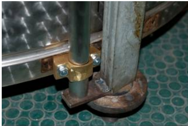
Slika 3.5: Vodilice od mjedi i cijev za vođenje
