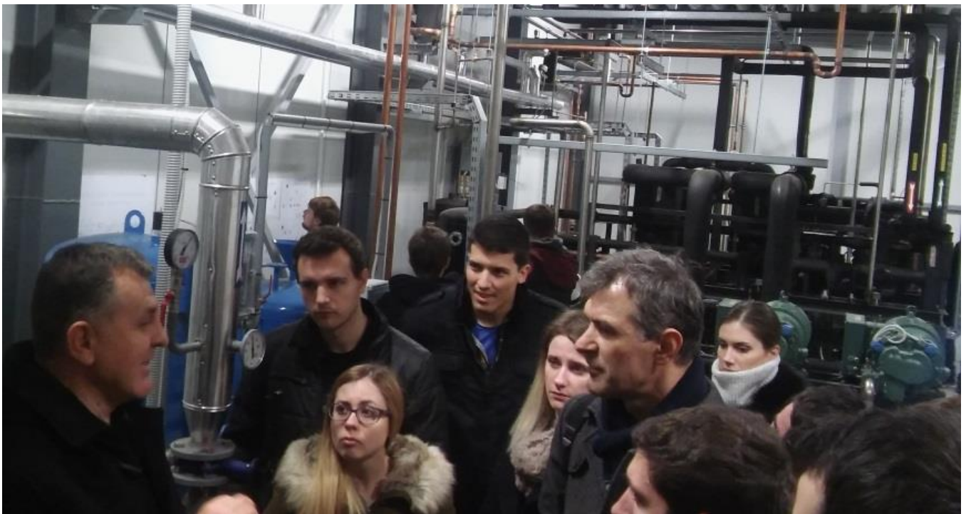
Razgledavanje kaskadnog rashladnog sustava CO 2 /R134a
