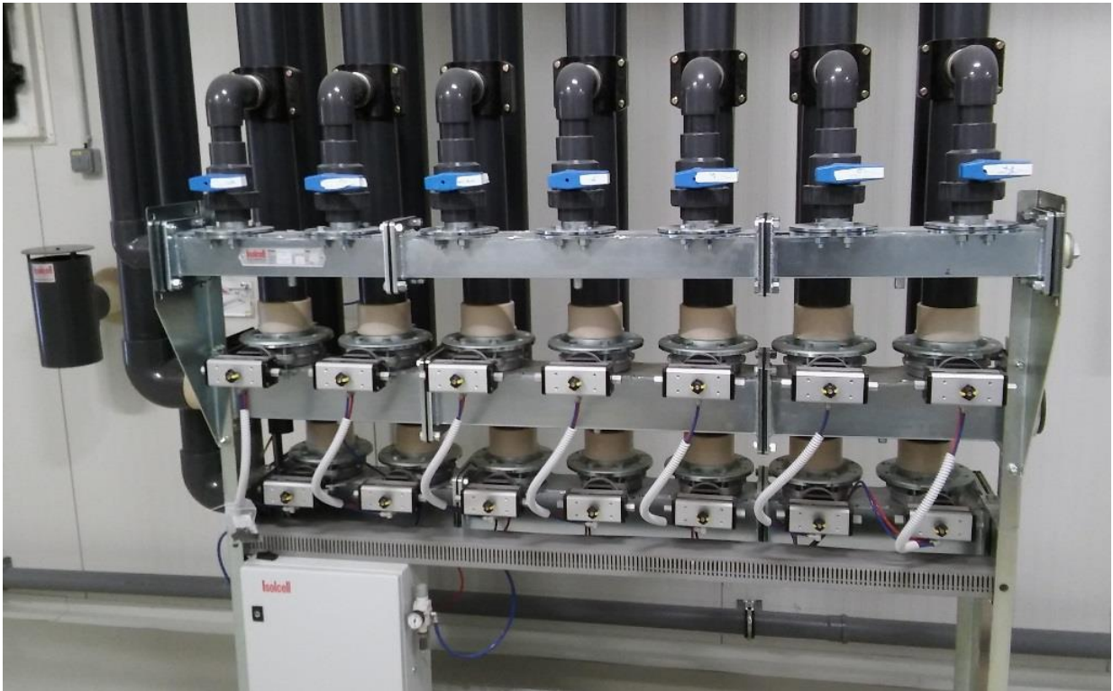
Cjevovod za regulacija sadržaja O 2 i CO 2 u hladionicama
