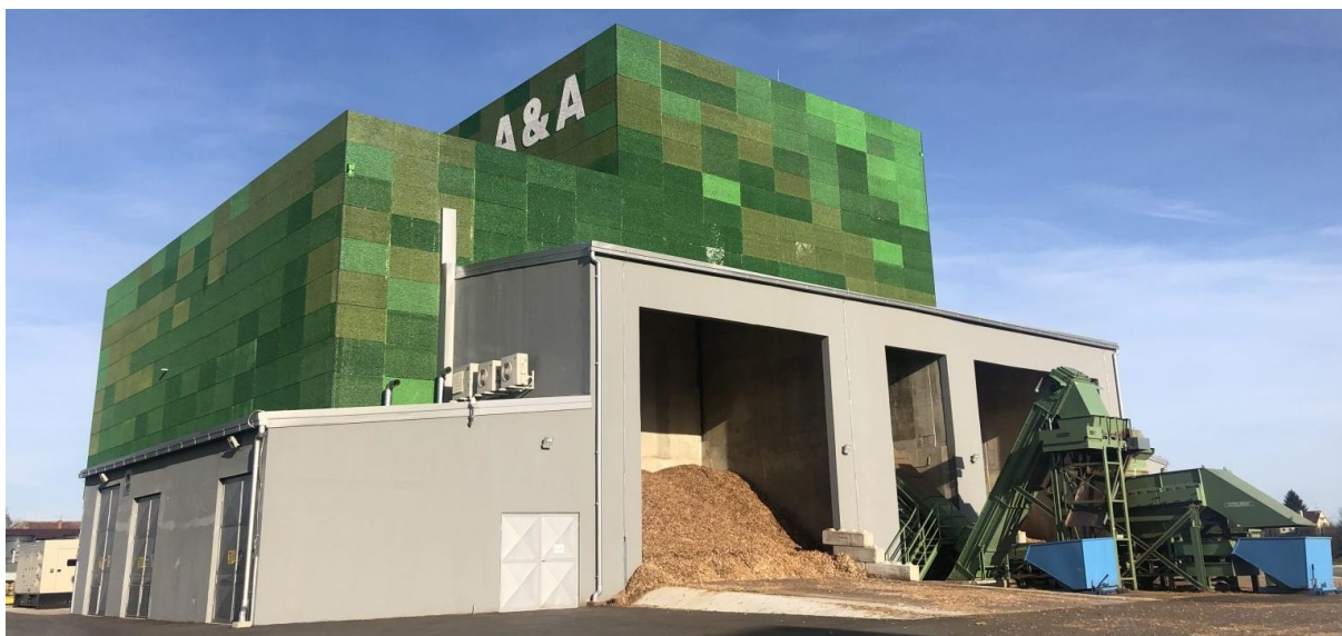
Slika 2.19 Fasadni paneli na kogeneracijskom postrojenju [104]
