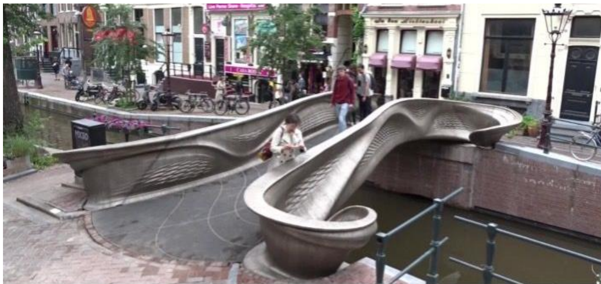
Slika 1. Most izrađen aditivnom proizvodnjom električnim lukom i žicom [37]
